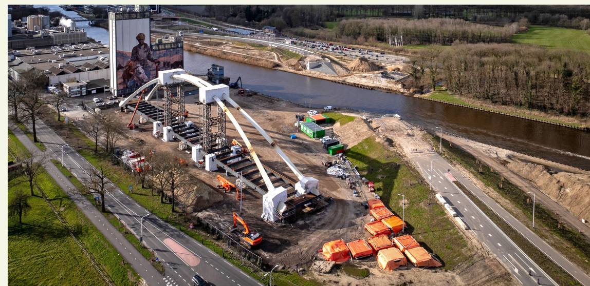
De afgelopen maanden vonden laswerkzaamheden plaats aan de brug op de kade. Op 6 en 7 juni wordt de brug met grote pontons over het Twentekanaal gelegd.
